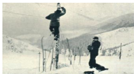
Zavádění nového telefonního spojení.
